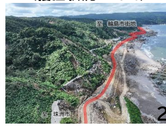
(復旧状況 R6. 9)
