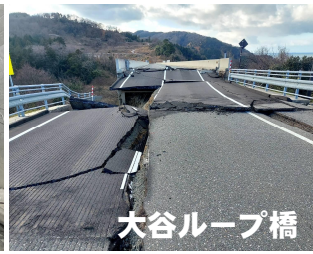
⑤ 大谷トンネル・ループ橋工区 (地震被災状況)
