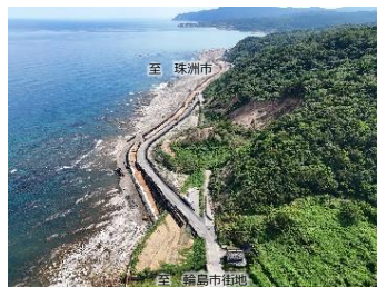
(復旧状況 R6. 8)
