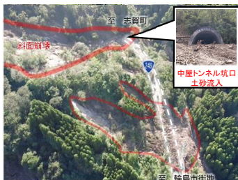
(大雨被災状況 R6. 9)
