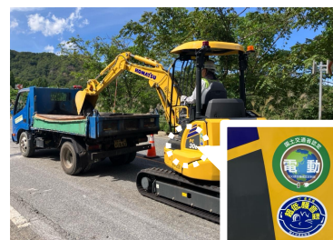
電動バックホウによる施工状況
