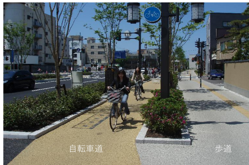
整備事例 自転車歩行者道分離 (国道7号 新潟県新潟市)
