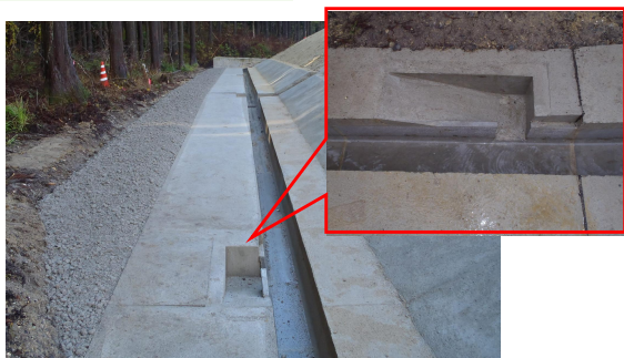
脱出斜路付き側溝
