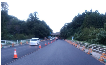
舗装施工状況
