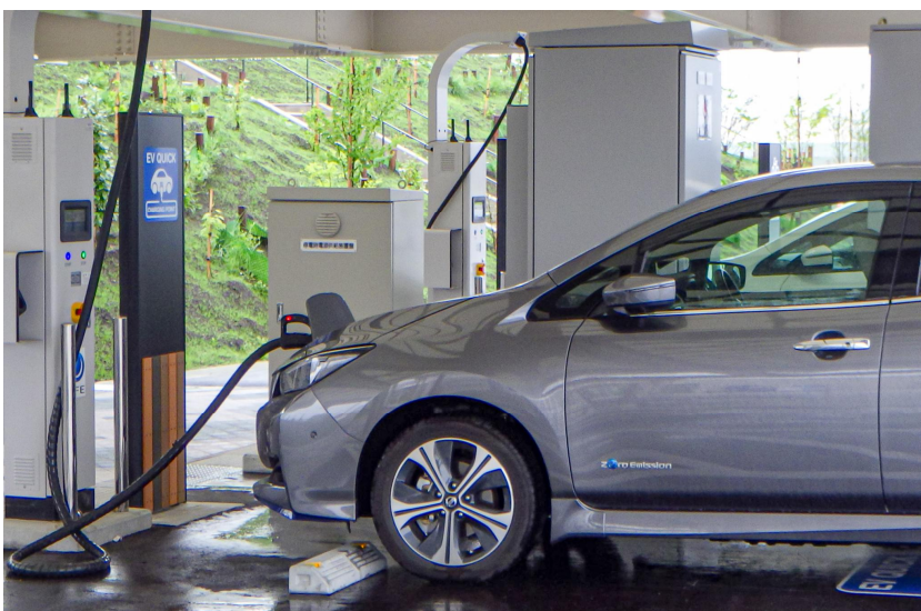
設置事例 道の駅「KOKOくろべ」(富山県黒部市)
