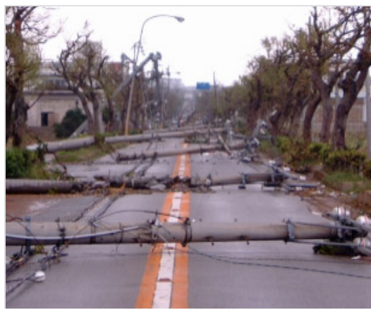
（台風による道路の被災状況）
