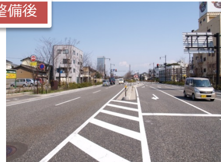
(電線共同溝整備:国道7号 新潟市中央区)
