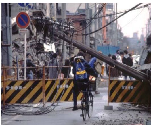
（阪神淡路大震災による被災状況）
