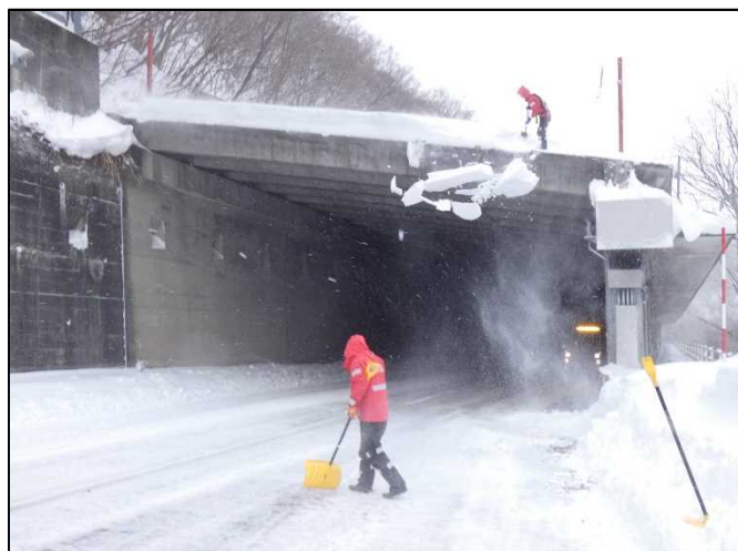
雪底処理【国道17号 新潟県湯沢町】 (R3.12.28撮影)
