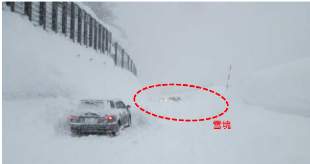
▲R4.2.6 国道17号三俣地先 雪塊崩落による通行止め発生
