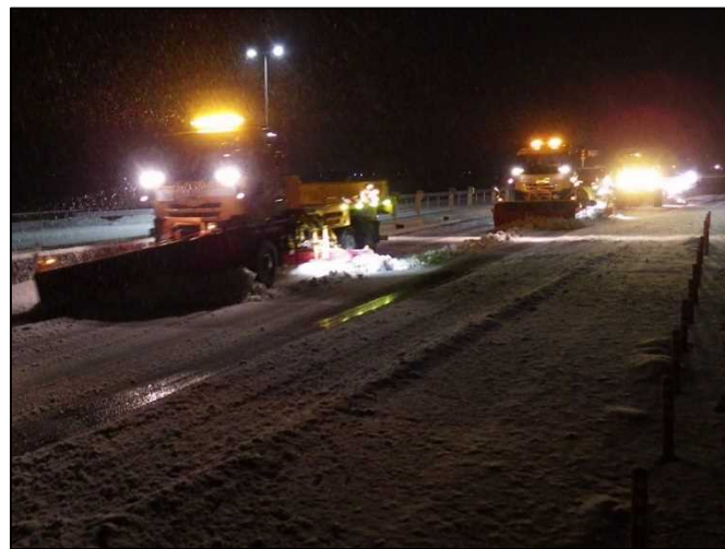
車道除雪【国道8号 石川県津幡町】 (R3.12.31撮影)
