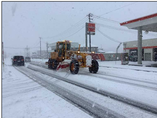
車道除雪【国道49号 新潟県阿賀町】 (R3.12.19撮影)
