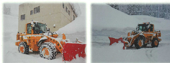
2022.3.7 町道所平大場線除雪作業の様子
