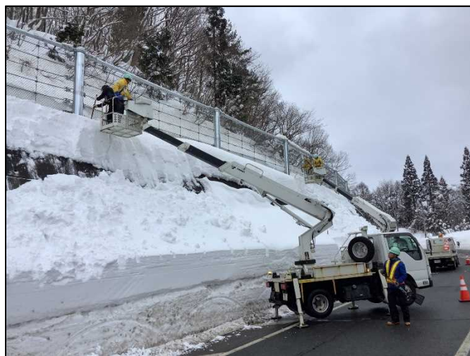
雪底処理【国道49号 新潟県阿賀町】 (R4.1.22撮影)
