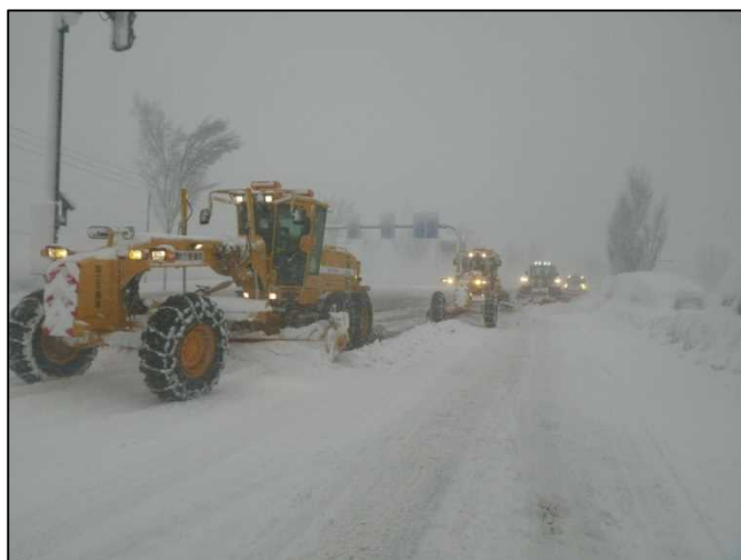
車道除雪【国道17号 新潟県湯沢町】 (R4.1.12撮影)
