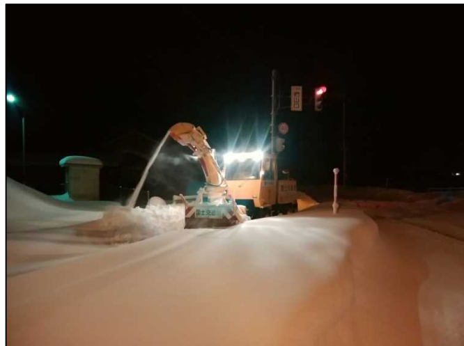
歩道除雪【国道8号 富山県入善町】 (R4.2.24撮影)
