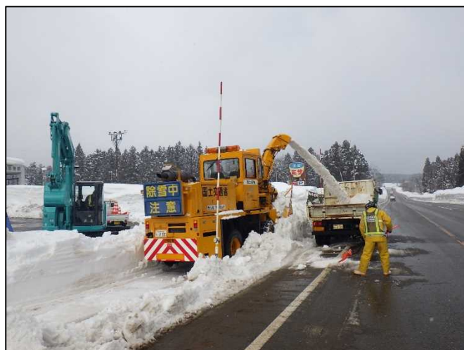
運搬排雪【国道18号 新潟県上越市】 (R4.1.28撮影)
