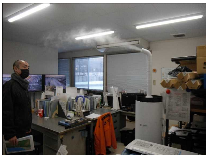
加湿器の設置(新潟県新潟除雪基地) (R4.1.5撮影)
