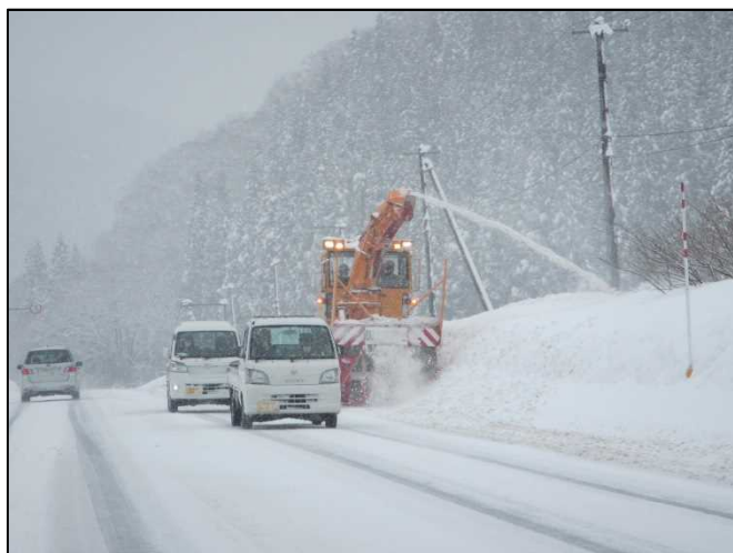
拡幅除雪【国道7号 新潟県村上市】 (R4.2.17撮影)
