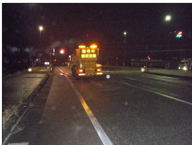
凍結防止剤散布【国道8号 石川県加賀市】 (R1.11.29撮影)
