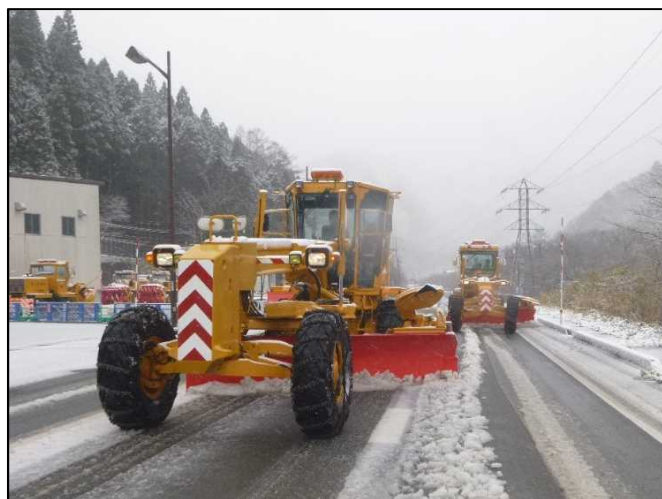
国道17号 新潟県湯沢町(R1.11.20撮影)
