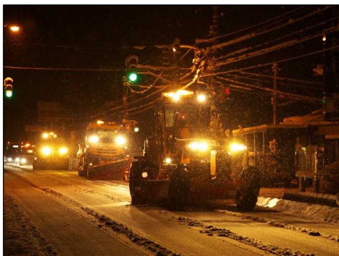
車道除雪【国道8号 富山県高岡市】 (R2.2.6撮影)
