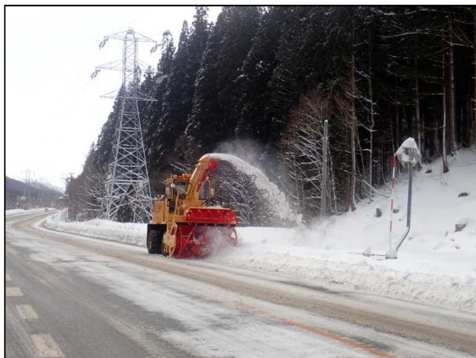
拡幅除雪【国道17号 新潟県湯沢町】 (R2.1.16撮影)
