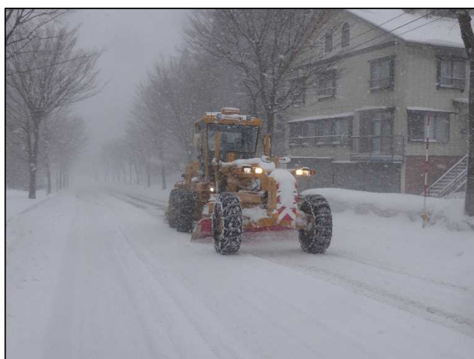
車道除雪【国道17号 新潟県湯沢町】 (R2.1.21撮影)
