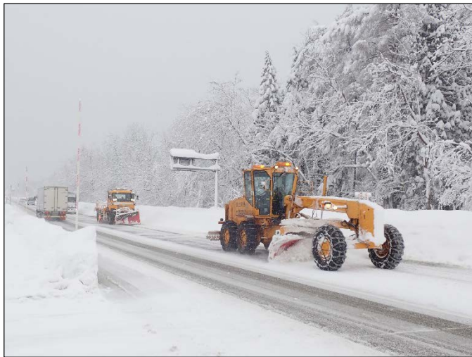
車道除雪【国道18号 新潟県上越市】 (H31.1.9撮影)
