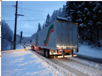
国道49号 阿賀町福取地先 (H30.12.19)
