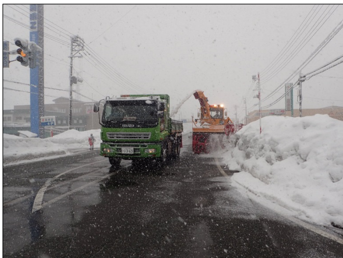
運搬排雪【国道17号 新潟県塩沢町】 (H31.1.24撮影)
