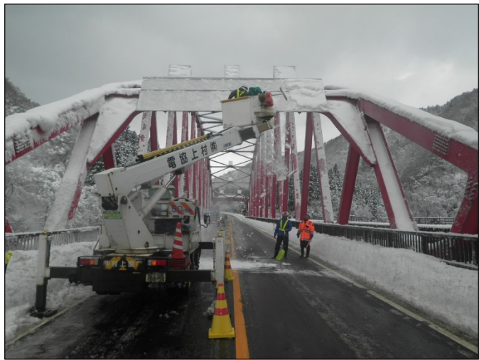
着雪処理【国道113号 新潟県関川村】 (H31.1.9撮影)
