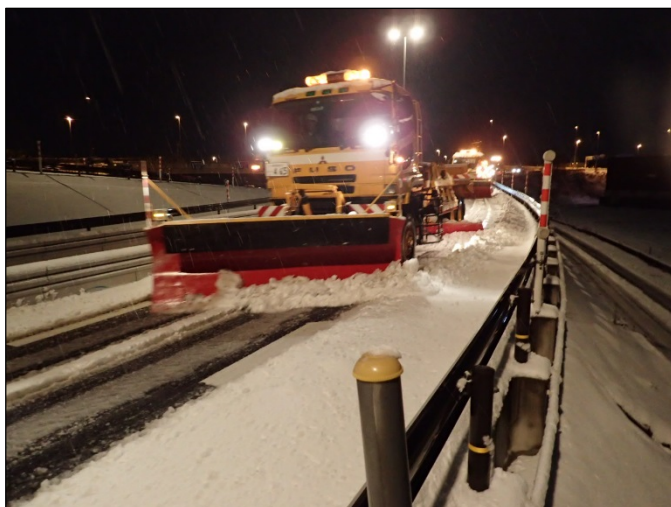
車道除雪【国道49号 新潟県新潟市東区】 (H31.1.27撮影)
