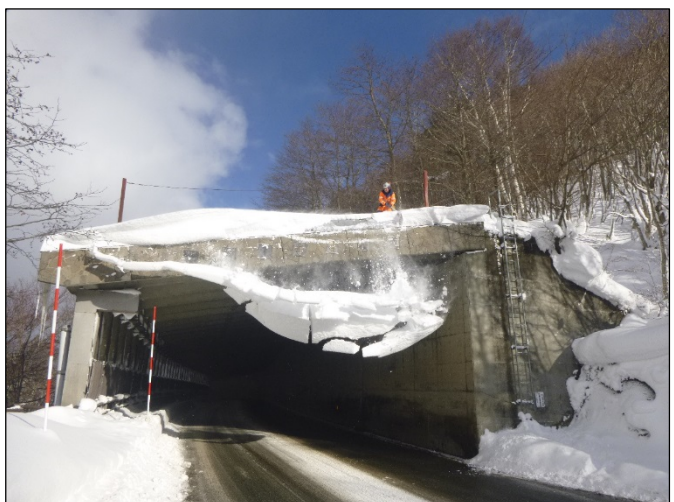
雪底処理【国道17号 新潟県湯沢町】 (H30.12.31撮影)
