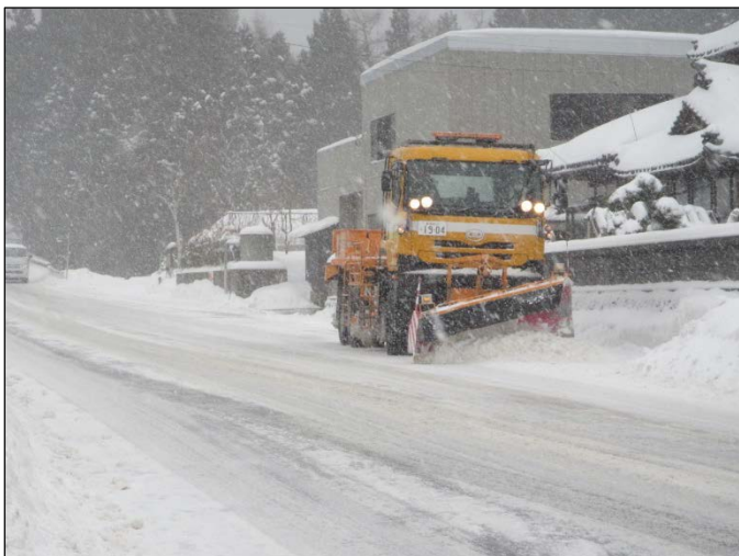
車道除雪【国道7号 新潟県村上市】 (H30.12.29撮影)
