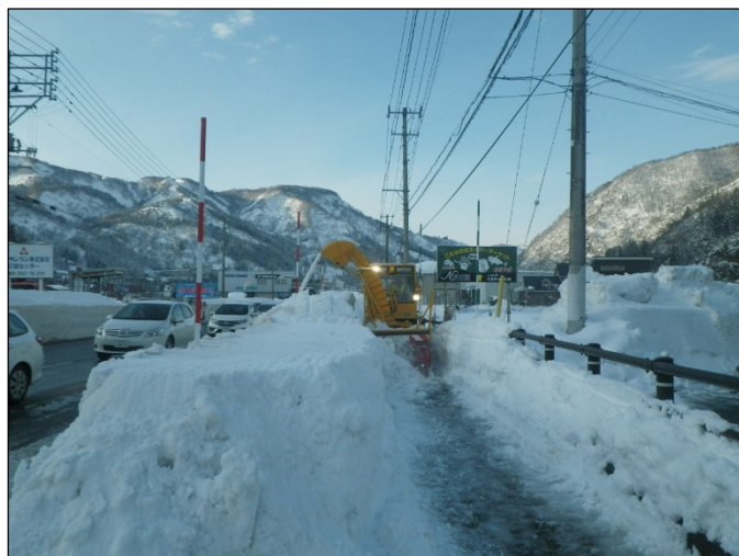
歩道除雪【国道17号 新潟県湯沢町】 (H31.1.10撮影)
