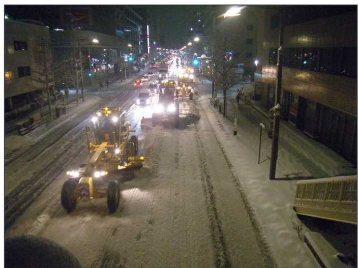
車道除雪【国道7号 新潟県新潟市】 (H28.1.24撮影)
