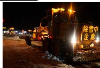
交差点単位で通行止めを行い、繰り 返し作業で厚い圧雪を削り取る
