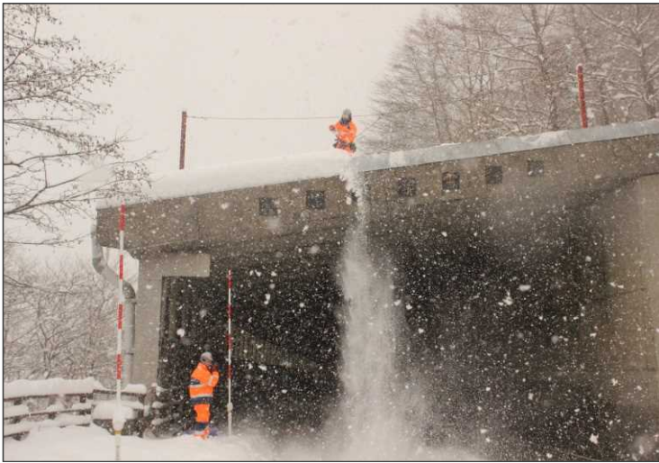
雪底処理【国道17号 新潟県南魚沼郡湯沢町】 (H27.12.29撮影)
