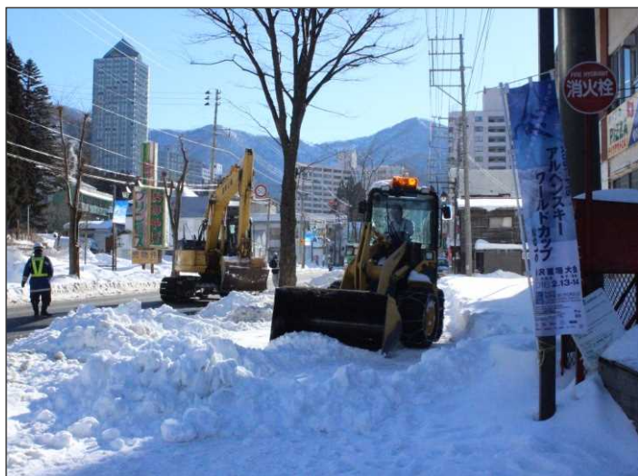
雪堤処理【国道17号 新潟県南魚沼郡湯沢町】 FISアルペンスキーW杯開催前の雪堤除去 (H28.2.4撮影)
