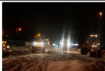
中之島工区6台の除雪機械に加え、 応援車両40台で圧雪を除去
