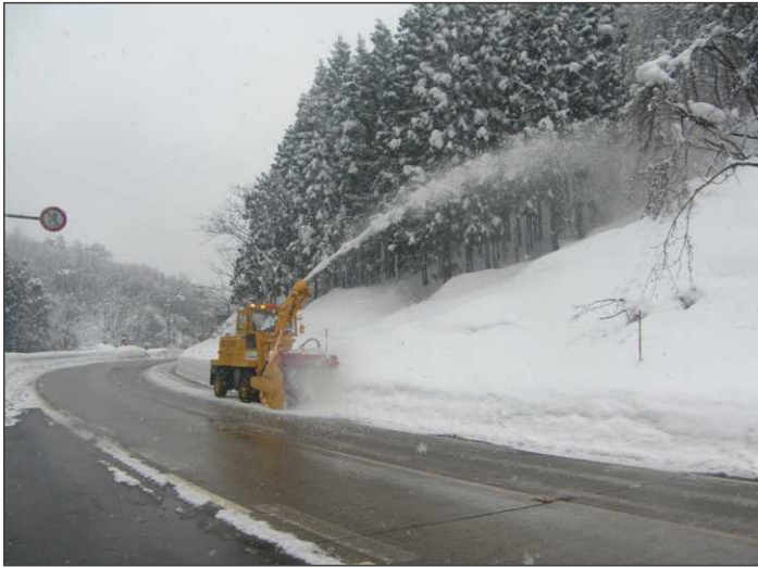
拡幅除雪【国道49号 新潟県東蒲原郡阿賀町】 (H28.2.5撮影)
