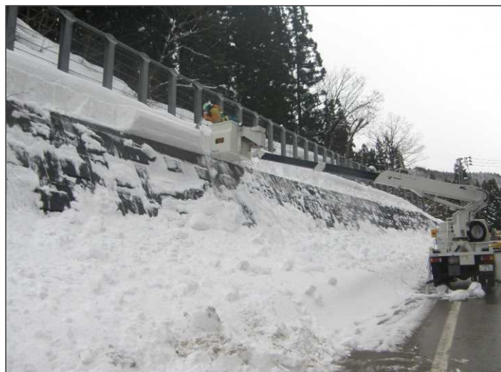
雪底処理【国道49号 新潟県東蒲原郡阿賀町】 (H28.1.23撮影)
