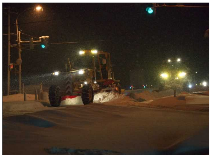
車道除雪【国道8号 富山県富山市】 (H28.1.25撮影)
