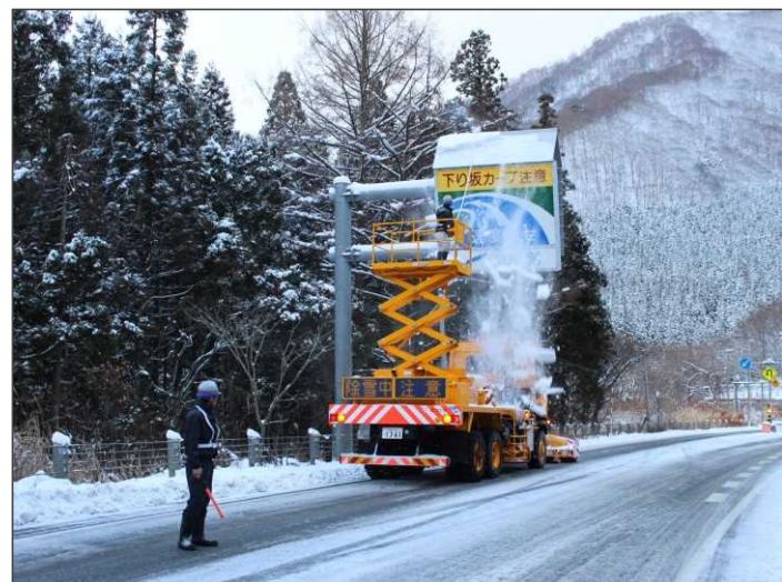
標識着雪処理【国道17号 新潟県南魚沼郡湯沢町】 (H27.12.18撮影)
