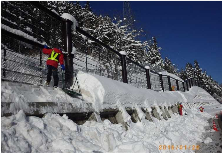
雪底処理【国道17号 新潟県南魚沼郡湯沢町】 (H28.1.26撮影)
