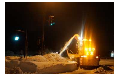
削り取った雪をロータリ除雪車による 拡幅除雪で積み上げ、車線確保
