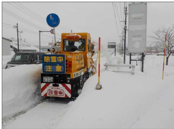
歩道除雪【国道17号 新潟県魚沼市】 (H28.1.25撮影)
