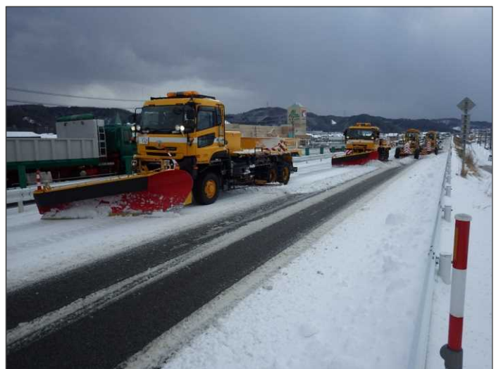
車道除雪【国道8号 石川県河北郡津幡町】 (H28.1.25撮影)
