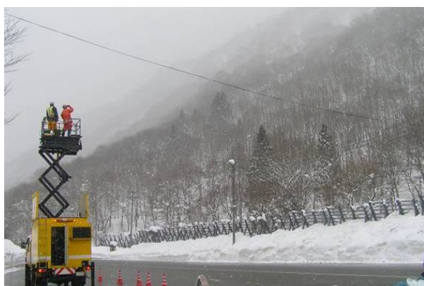
国道17号 新潟県湯沢町 法面点検車による雪崩点検(H23.1.19撮影)
