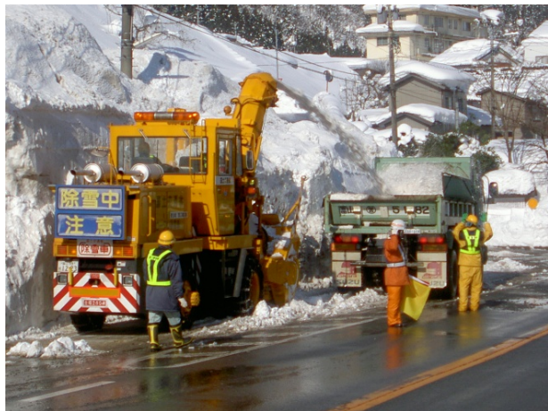
国道41号 富山県富山市楡原 運搬排雪状況 (H23.2.2撮影)
