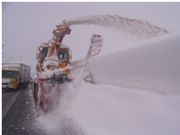
国道17号 新潟県南魚沼市九日町 除雪状況 (H23.1.31撮影)
