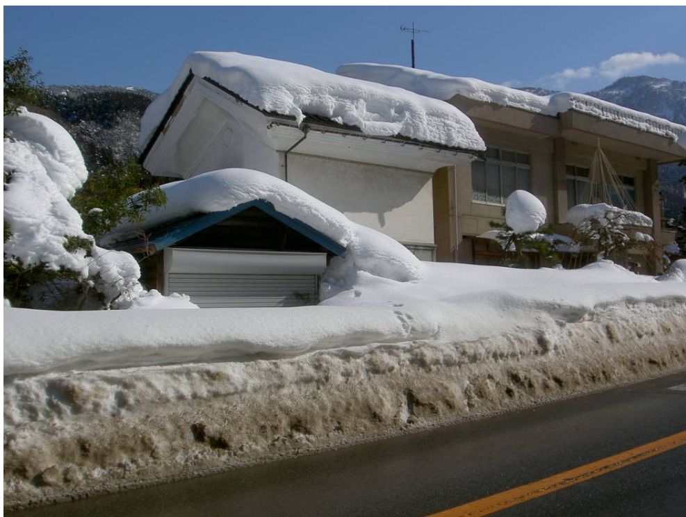
国道41号 富山市猪谷 車の出入りができない車庫 (H23.2.7撮影)
