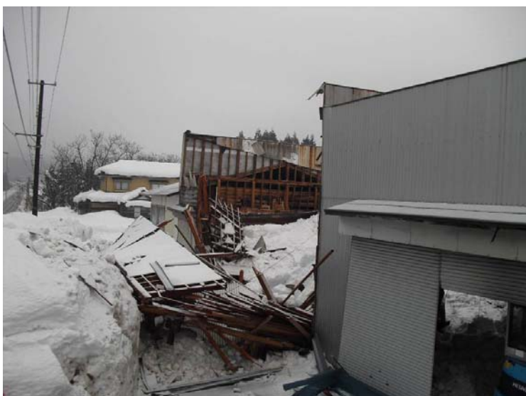
新潟県村上市大須戸 作業場倒壊 写真提供: 村上市 (H23.2.4撮影)
