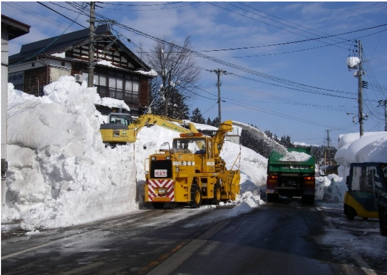
国道252号魚沼市内の排雪作業 (H23.2.3撮影)
