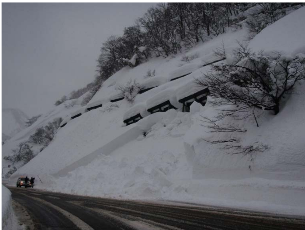
石川県白山市東二口地先 落雪により車線減少(国道157号) 写真提供: 石川県 (H23.2.1撮影)
