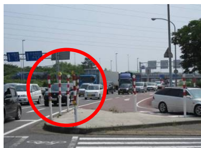
伸縮式デリネータの残置状況
