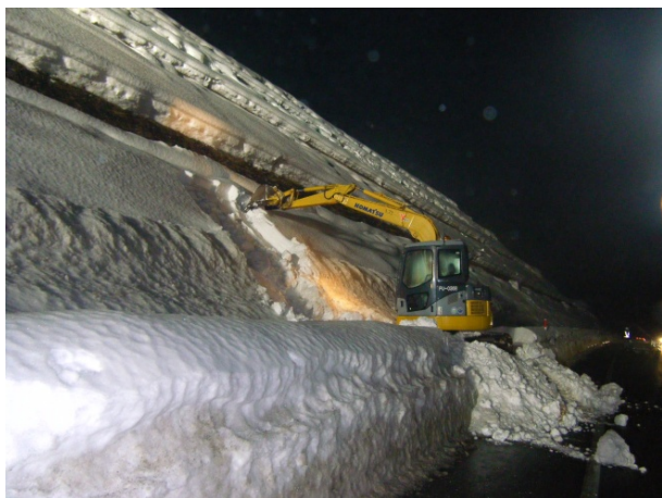
国道159号 石川県津幡町 雪庇処理 (H23.2.3撮影)
