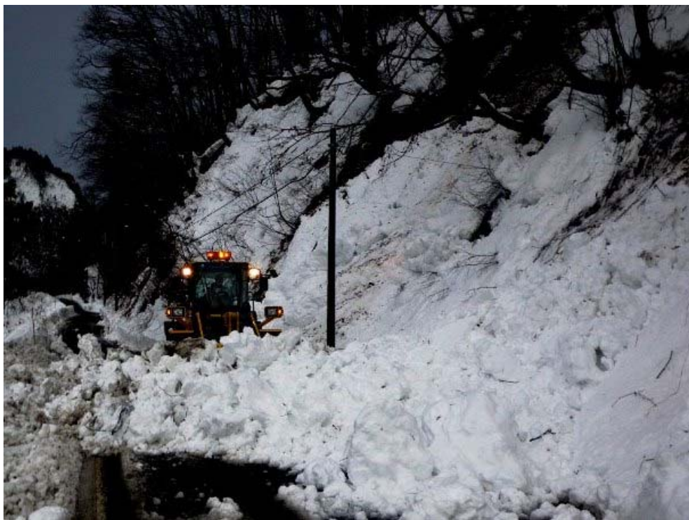
新潟県阿賀町豊川 雪崩発生による集落孤立を復旧するため処理をしている状況 写真提供:阿賀町(H23.2.4撮影)
