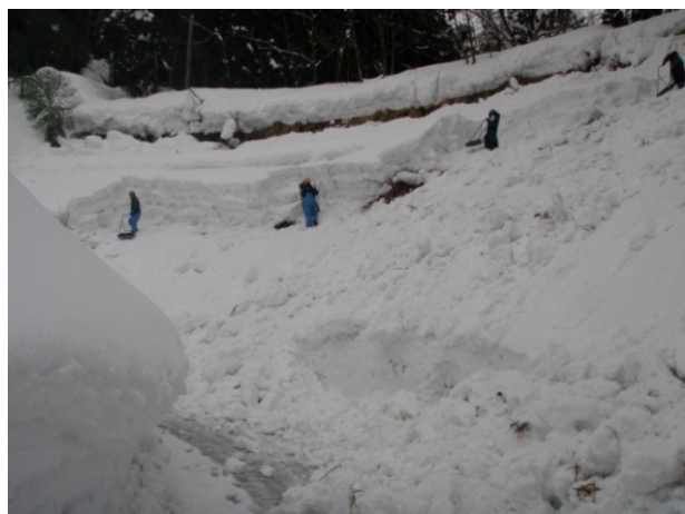
新潟県上越市名立区折居 雪底処理、雪崩点検・処理作業 写真提供: 上越市 (H23.1.28撮影)
