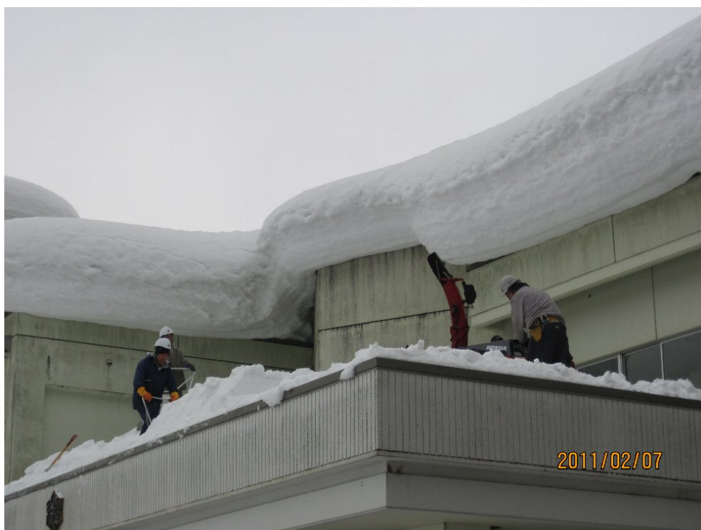
新潟県小千谷市塩殿地内 公共施設等(役場、郵便局)の雪下ろし 写真提供:小千谷市(H23.2.7撮影)
