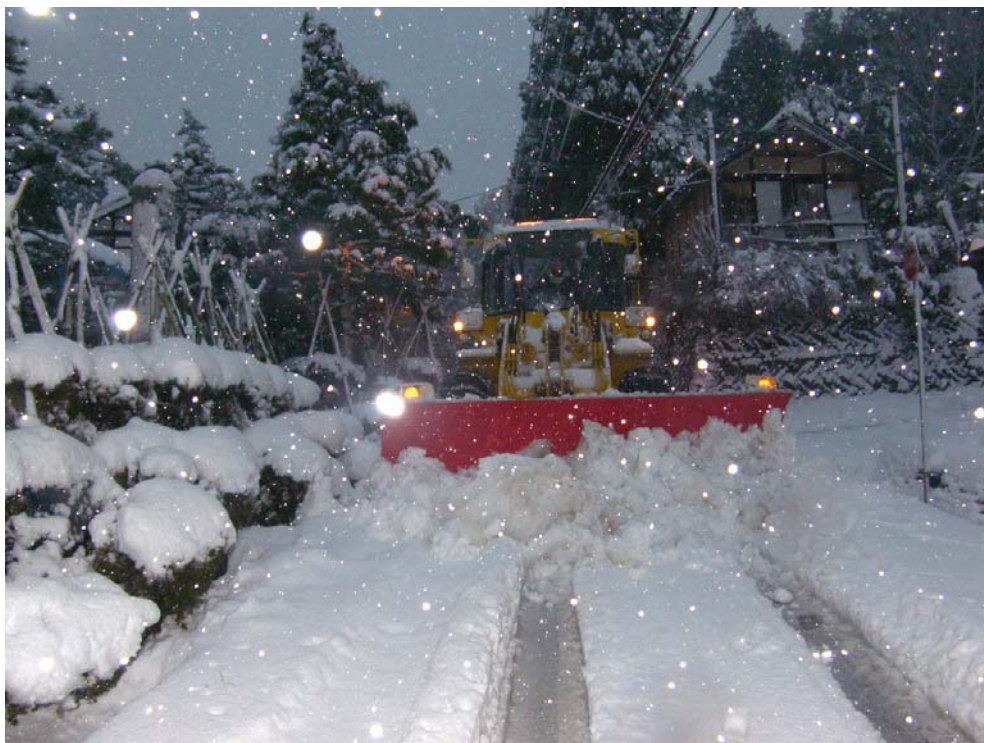
石川県羽咋管内 狭い道路での除雪苦慮 写真提供: 石川県 (H23.1.8撮影)
