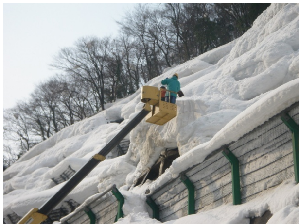
国道156号 富山県砺波市小牧 雪庇処理 (H23.2.4撮影)
