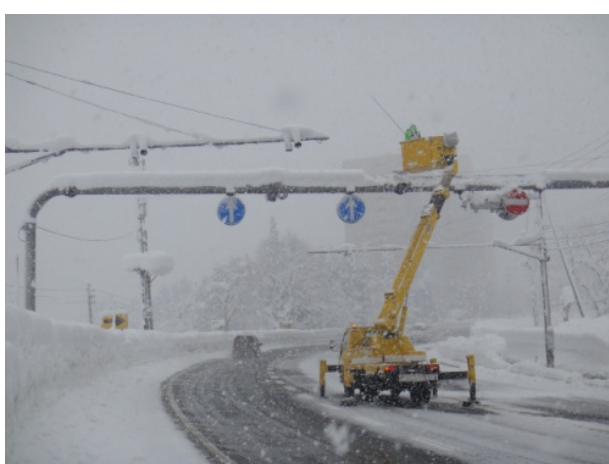
国道17号 新潟県湯沢町 標識の積雪を除雪 (H23.1.20撮影)
