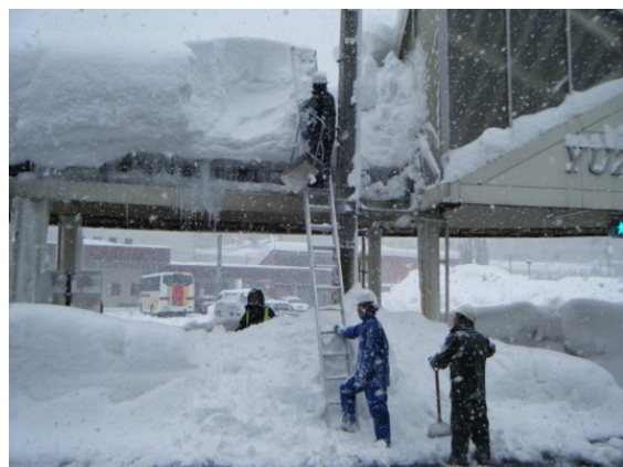
湯沢町 公共施設等の雪下ろし 写真提供: 湯沢町(H23.1.18撮影)
