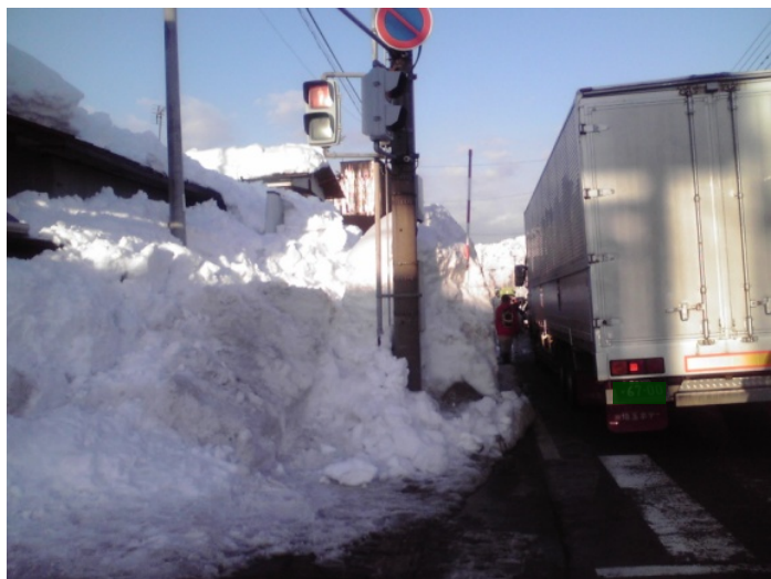
国道17号 新潟県南魚沼市塩沢 下ろした屋根雪が歩道をふさぐ、危険な歩行者 写真提供：南魚沼市（H23.2.3撮影）
