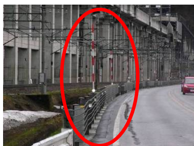
スノーポールの残置状況
