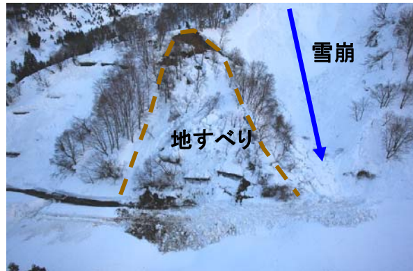
平成23年3月12日 雪崩・地滑り発生 国道405号 十日町市松之山月池 (写真提供 新潟県)
