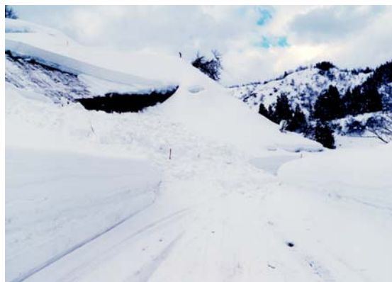
(主) 柏崎高浜堀之内線 魚沼市竜光 雪崩発生 写真提供:新潟県(H23.1.17撮影)
