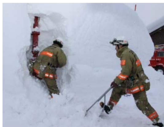
三条市葎谷 雪に埋もれた消火栓 写真提供: 三条市 (H23.1.31撮影)
