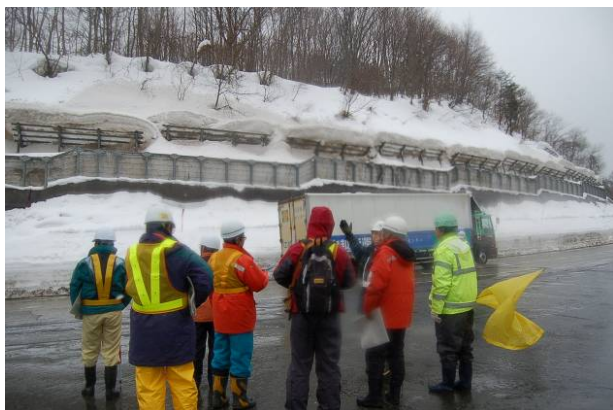
国道49号 新潟県阿賀町鳥井 雪崩パトロール状況(H23.2.18撮影)
