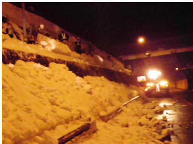
国道8号 富山県小矢部市安楽寺 雪庇処理 (H23.2.5撮影)
