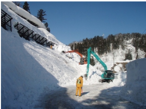
新潟県小千谷市東山地内 雪底処理、雪崩点検・処理作業 写真提供: 小千谷市 (H23.2.3撮影)
