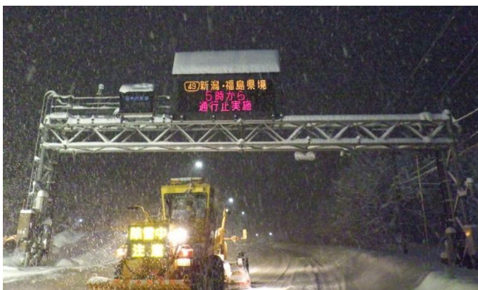
1月24日 国道49号 除雪状況
