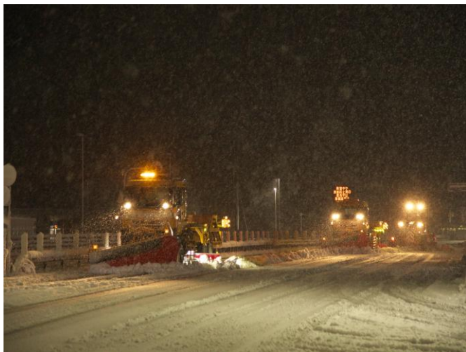
車道除雪【国道8号 富山県小矢部市】 (R8.1.3撮影)
