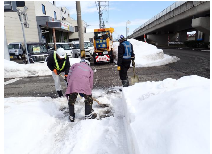
歩道除雪【国道8号 石川県金沢市】 (R8.2.4撮影)
