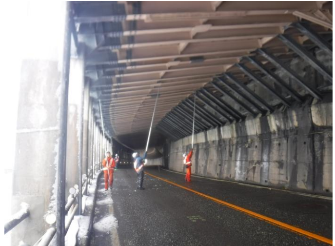
つらら処理【国道8号 新潟県糸魚川市】 (R8.1.23撮影)
