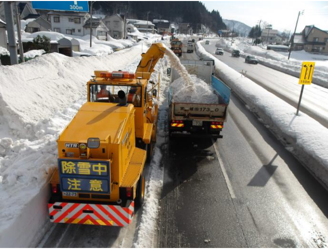
運搬排雪【国道17号 新潟県長岡市】 (R8.2.5撮影)
