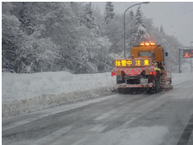
車道除雪【国道18号 新潟県妙高市】 (R8.1.8撮影)
