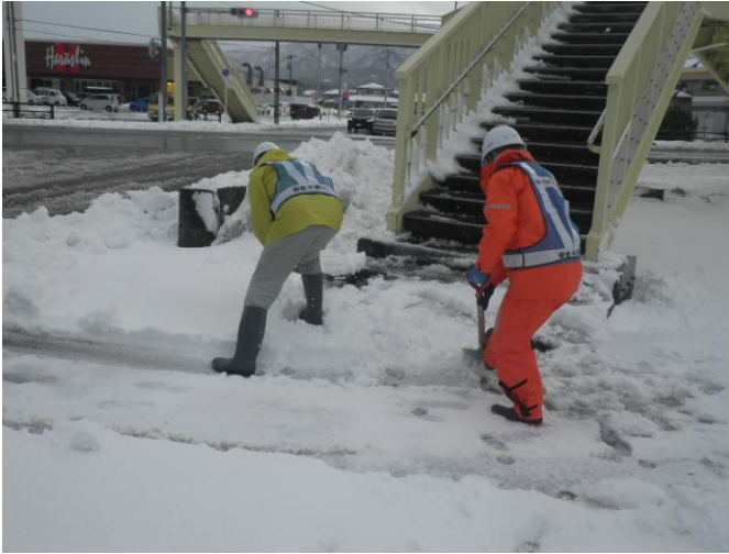
人力除雪【国道7号 新潟県村上市】 (R8.1.9撮影)
