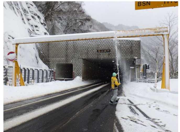
着雪処理【国道49号 新潟県阿賀町】 (R8.2.7撮影)
