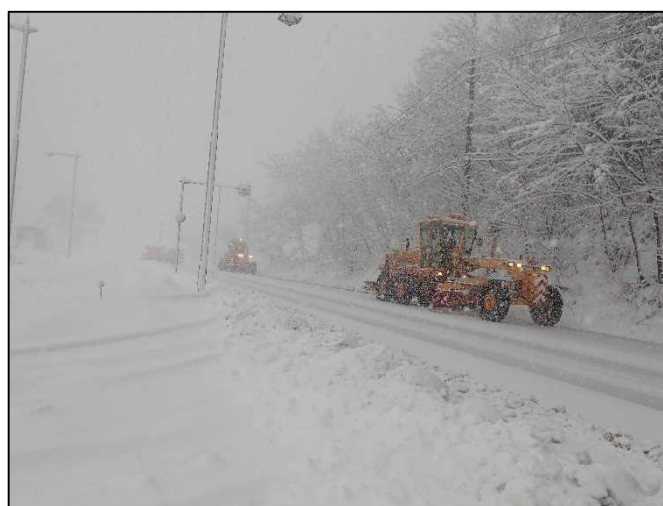
車道除雪【国道18号 新潟県上越市】 (R5.1.24撮影)
