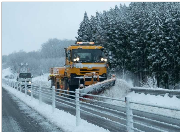
拡幅除雪【E7日東道 新潟県村上市】 (R4.12.23撮影)
