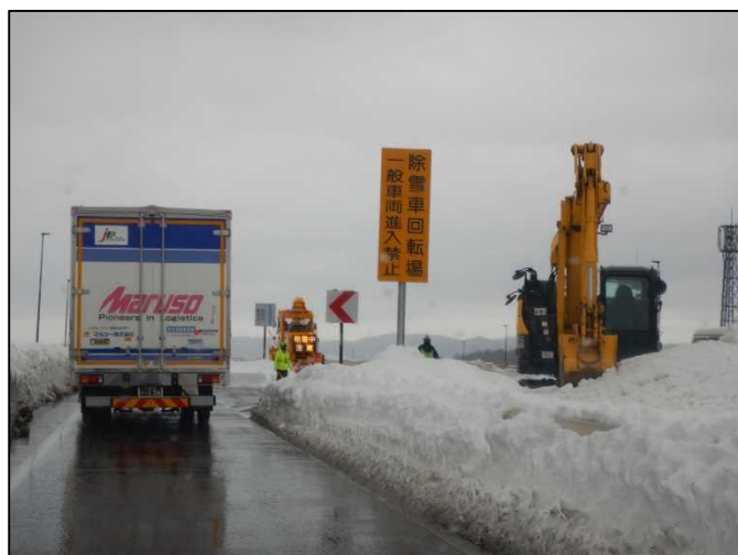
除雪車回転場の除雪【国道8号 新潟県柏崎市】 (R4.12.22撮影)
