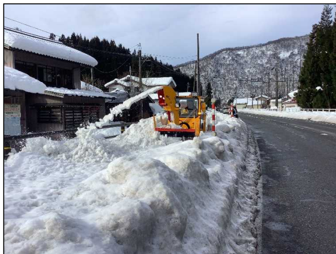
歩道除雪【国道49号 新潟県阿賀町】 (R4.12.21撮影)
