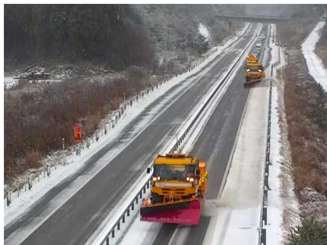
▲国道470号 石川県穴水町 (R4.12.18)
