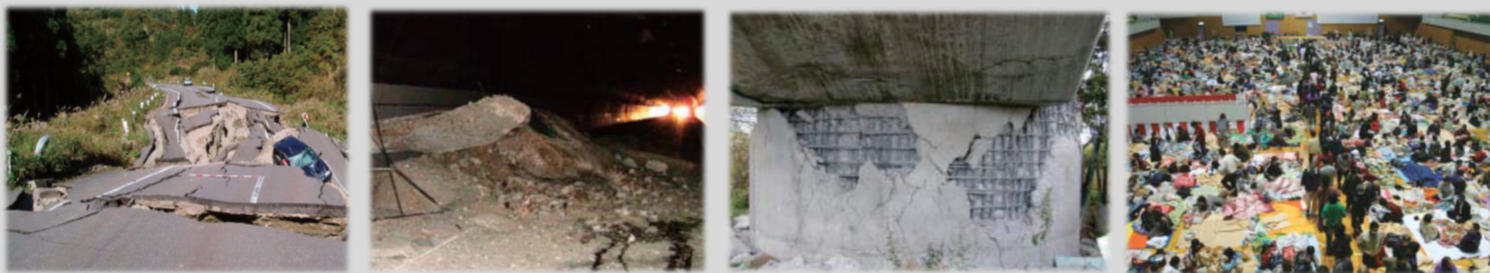
写真：左から 陥落した国道 253 号（旧新潟県堀之内上稲倉）、国道 17 号和南津トンネルのコンクリート剥落、国道 17 号小千谷大橋橋脚被の破損、被災 3 日目の避難所
