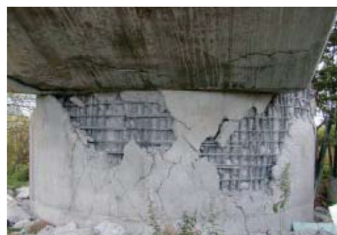
国道17号小千谷大橋橋脚の破損
