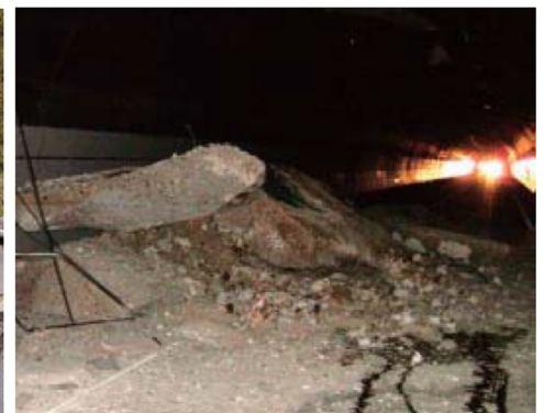
国道17号和南津トンネルのコンクリート剥落
