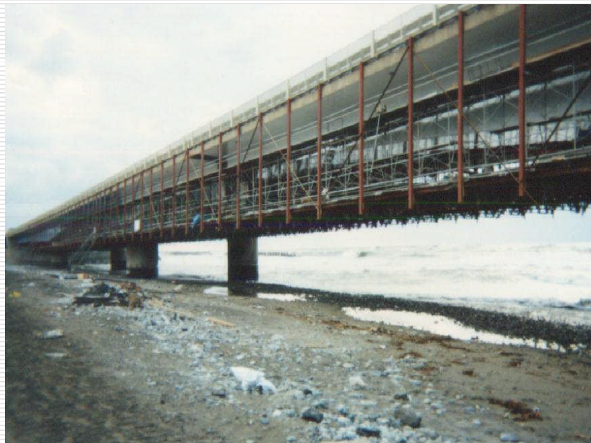
橋梁の補修工事全景
