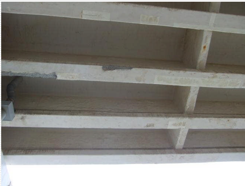
第7径間：断面修復
