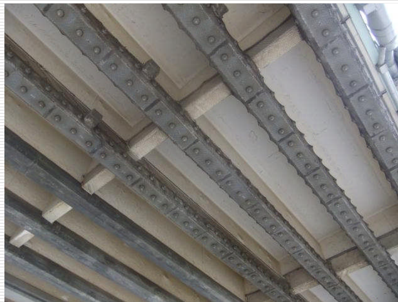
第8径間：電気防食
