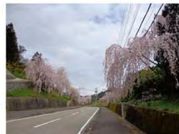
国道438号線法面 約18年生
