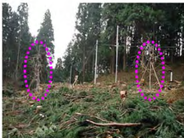
障害樹木伐採後の枝垂れ桜の植樹
