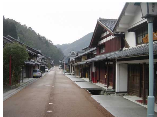
整備後の様子(平成20年)
