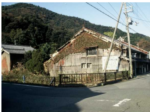
修復前の旧逸見勘兵衛家(昭和 60 年)
