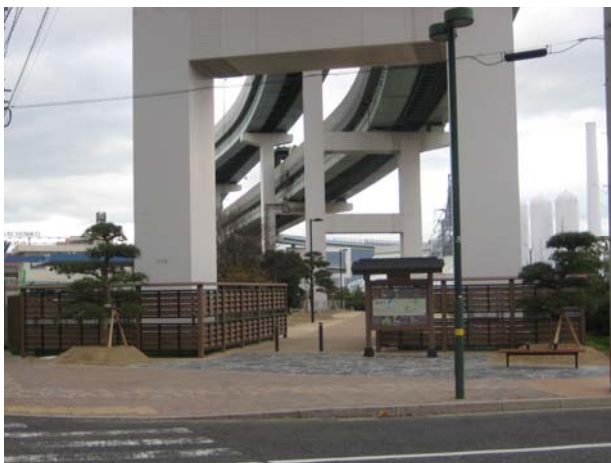
完成した東田遊歩道
