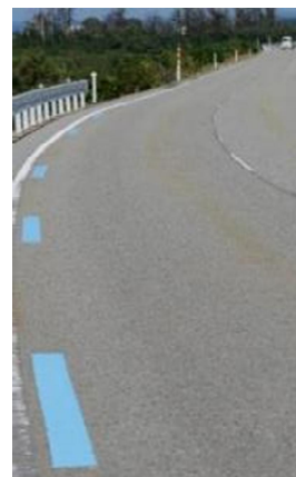
R5 : ブルーラインの設置、 矢羽根式路面標示、路面標示シートを整備
