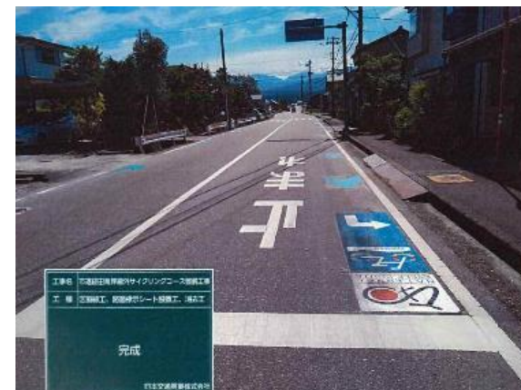
R5 : ブルーラインの設置、 矢羽根式路面標示、路面標示シートを整備
