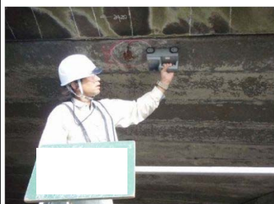
鋼材探査状況
