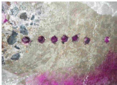
中性化試験状況(ドリル孔)
