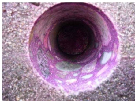
中性化試験状況(コア孔)
