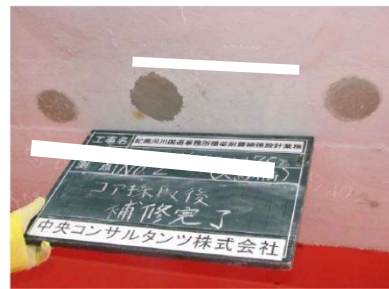
採取跡補修状況
