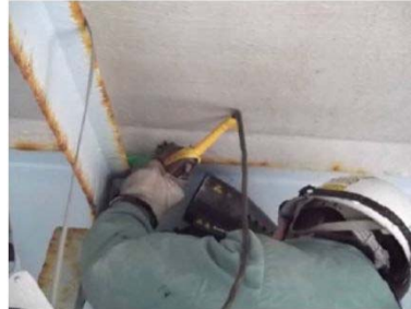
磁粉探傷試験状況
