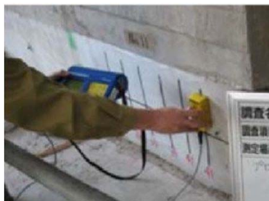
調査状況(電磁誘導法)
