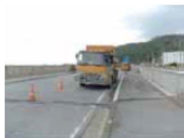
載荷試験状況
