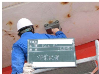
調査状況(電磁波レーダー法)
