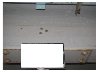
採取跡補修状況
