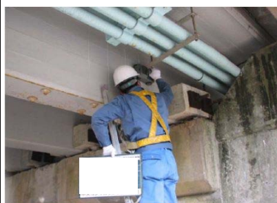
鉄筋探査状況
