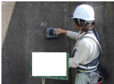
鉄筋探査状況
