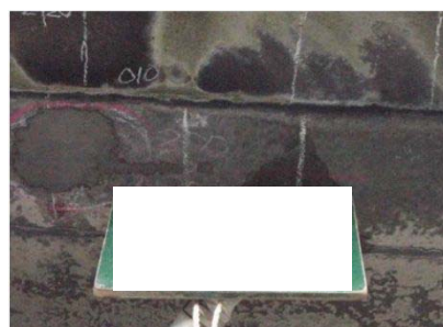
採取跡補修状況
