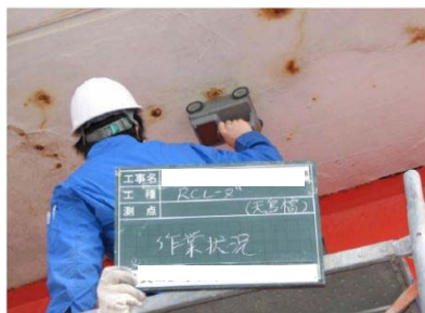
鉄筋探査状況
