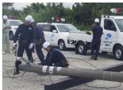
写真③ 倒壊電柱の除去訓練
