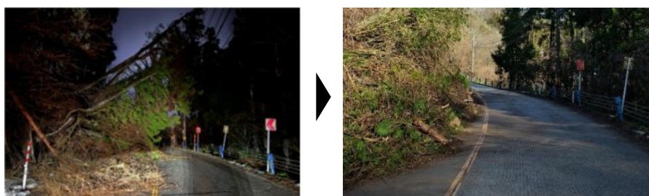
(主)七尾輪島線 電線にかかった倒木
