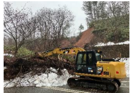
斜面崩落箇所の道路啓開
