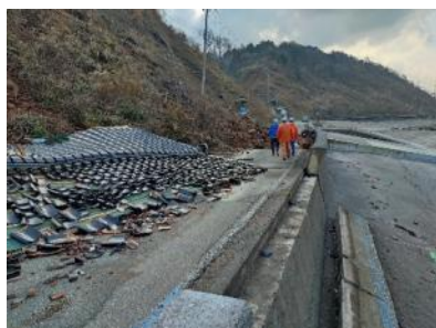
沿道建物倒壊箇所
