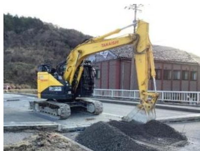
段差・亀裂箇所の道路啓開
