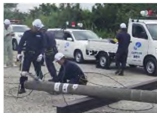
写真③ 倒壊電柱の除去訓練
