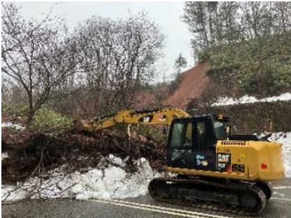
斜面崩落箇所の道路啓開
