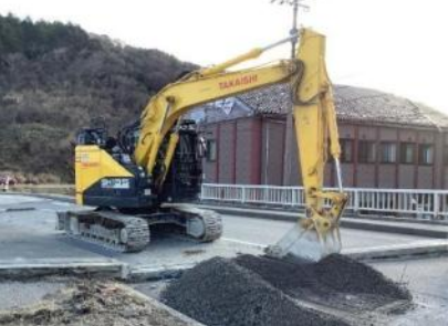
段差・亀裂箇所の道路啓開
