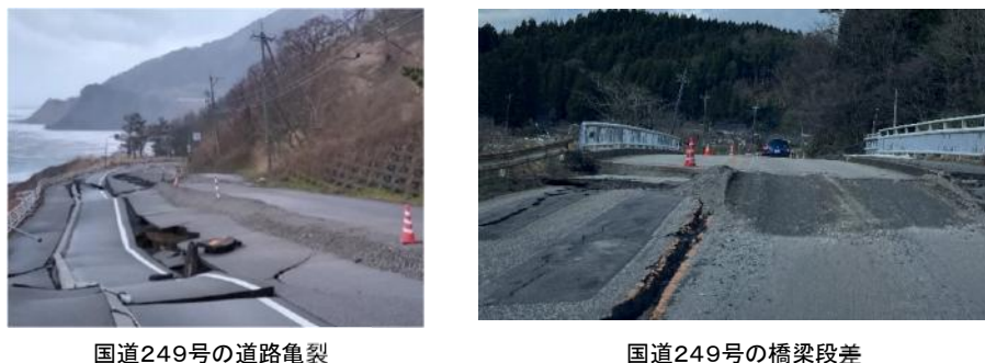
図 4.1.3 能登半島地震における被災状況(段差・路面亀裂)
