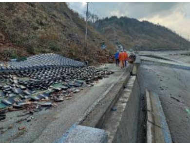
沿道建物倒壊箇所
