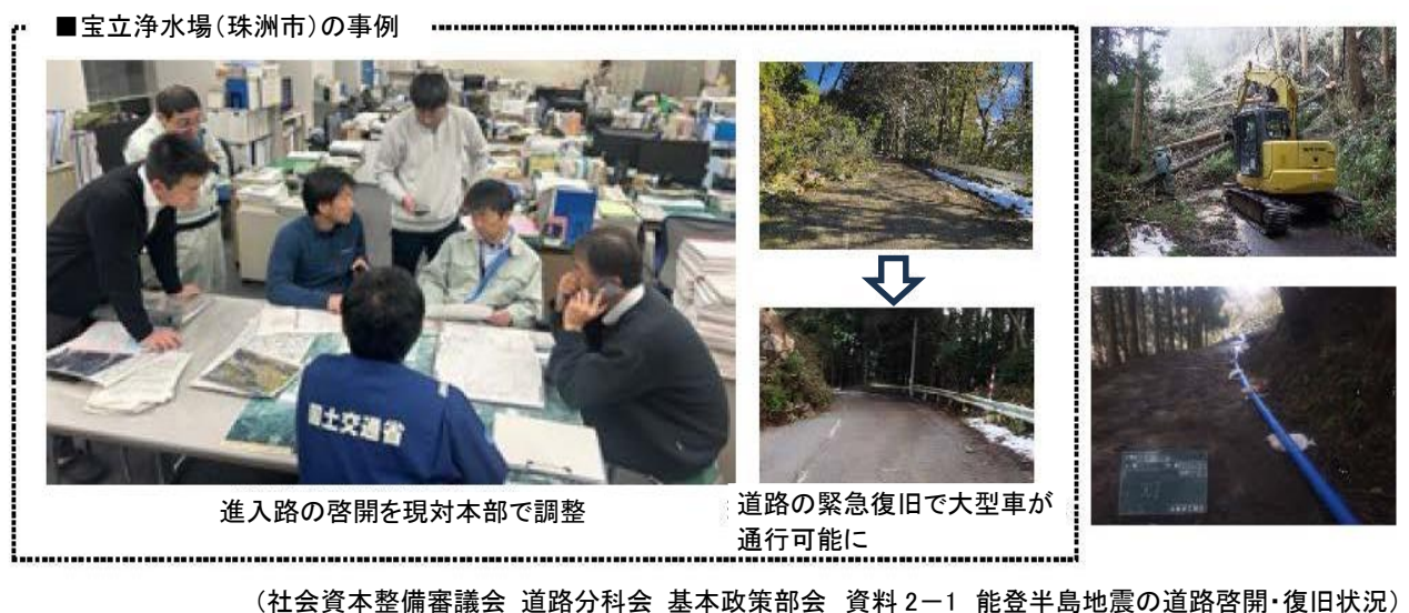
図 3.2.3 インフラ事業者と連携して道路啓開を実施した例(令和6年能登半島地震)
