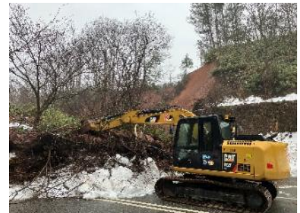
斜面崩落箇所の道路啓開
