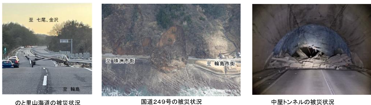
図 4.1.1 能登半島地震における主な大規模被災状況
