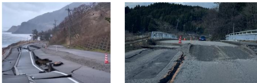
国道249号の道路亀裂 国道249号の橋梁段差
