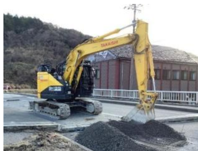
段差・亀裂箇所の道路啓開
