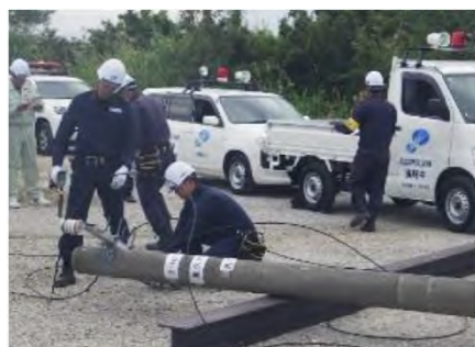
写真③ 倒壊電柱の除去訓練
