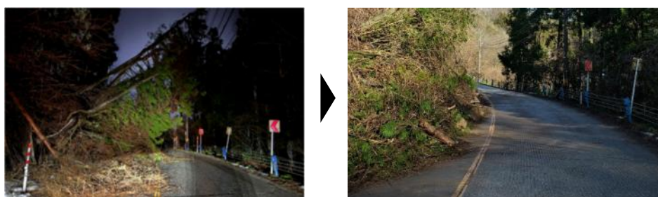
(主)七尾輪島線 電線にかかった倒木 道路啓開後
