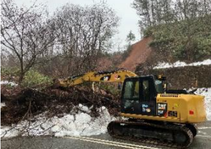
斜面崩落箇所の道路啓開
