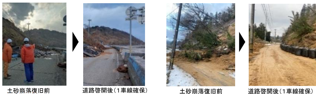
図 4.1.2 能登半島地震における道路啓開(左から 1,2 枚目:国道 249 号 左から 3,4 枚目:(一)高屋出田線)
