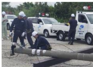
写真③ 倒壊電柱の除去訓練
