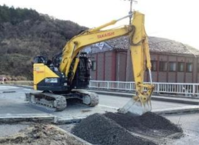
段差・亀裂箇所の道路啓開
