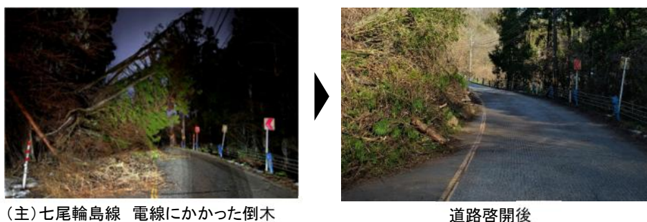
図 4.1.4 能登半島地震における被災状況(倒木・電柱倒壊)
