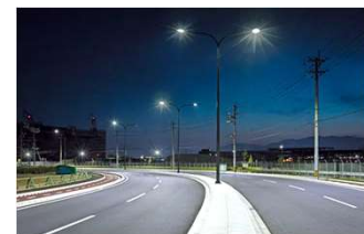
道路照明のLED化
