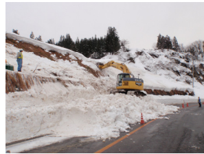
写真2 斜面雪処理による 片側交互通行規制状況
