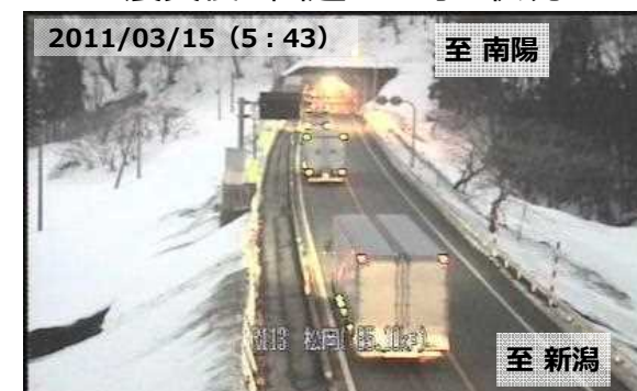
▼震災後の国道113号の状況
