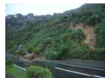
台風15号(H23.9)による法面崩壊写真
