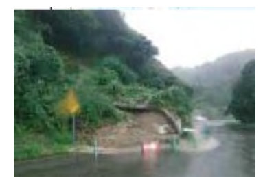
台風15号(H23.9)による法面崩壊写真
