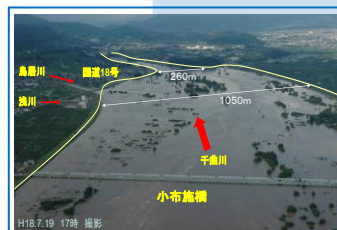
立ヶ花狭窄部掘削
