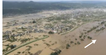
長野市穂保地先の堤防決壊、浸水被害状況
