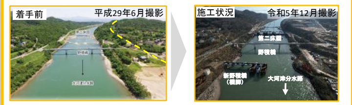
56:大河津分水路改修事業 (大河津分水路)
