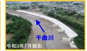
令和3年7月撮影 長野県東御市 本海野地区 復旧状況
