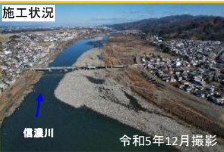
49: 小千谷市 東栄地区 (信濃川 右岸)
