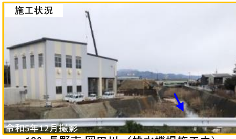
106: 長野市 岡田川 (排水機場施工中)
