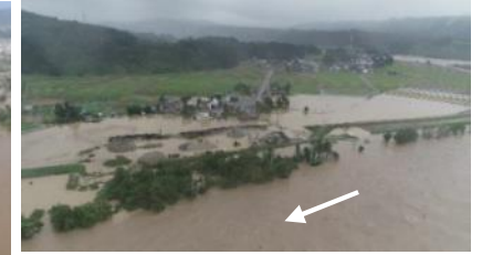
新潟県小千谷市内における浸水被害状況
