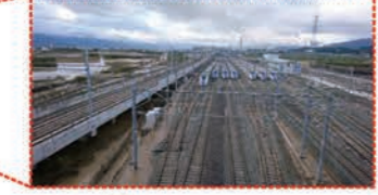
長野新幹線 車両センター (JR東日本) 浸水状況
