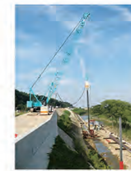
浸透対策工法の実施例 (川表法尻に遮水矢板を打設)
