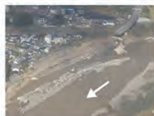
洪水時の侵食による被災 (東御市海野地先)
