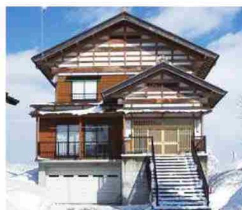
高床式住宅の事例 (新潟県十日町市)
