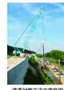
浸透対策工法の実施例 (川表法尻に遮水矢板を打設)
