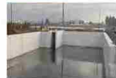
長野市 北堀雨水調整池
