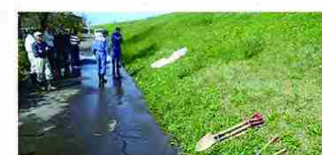
堤防からの漏水
