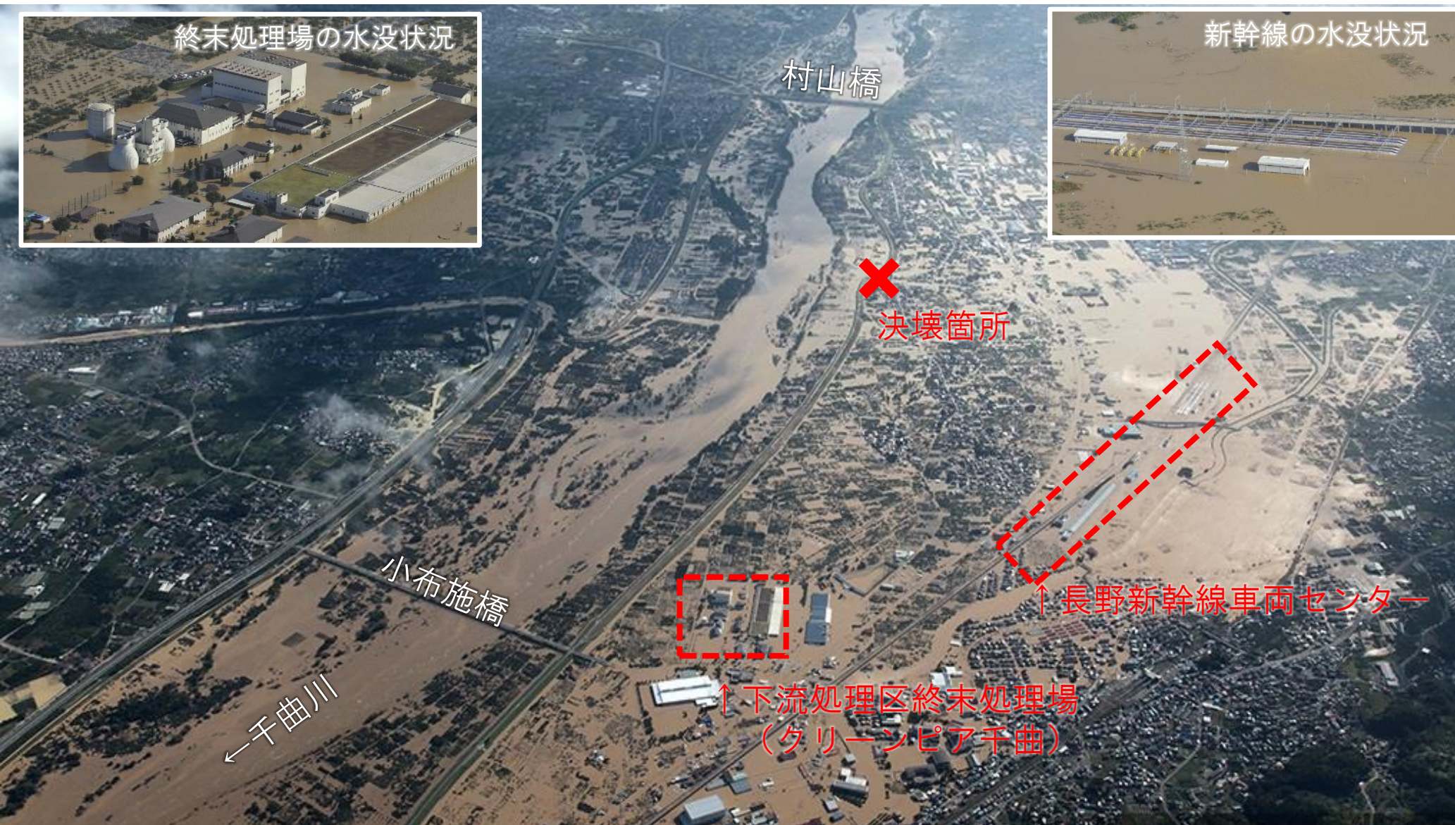
千曲川小布施橋付近左岸を望む(令和元年10月13日 15時頃)
