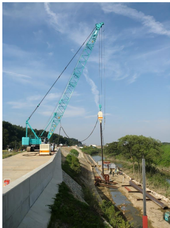
浸透対策工法の実施例 (川表法尻に遮水矢板を打設)
