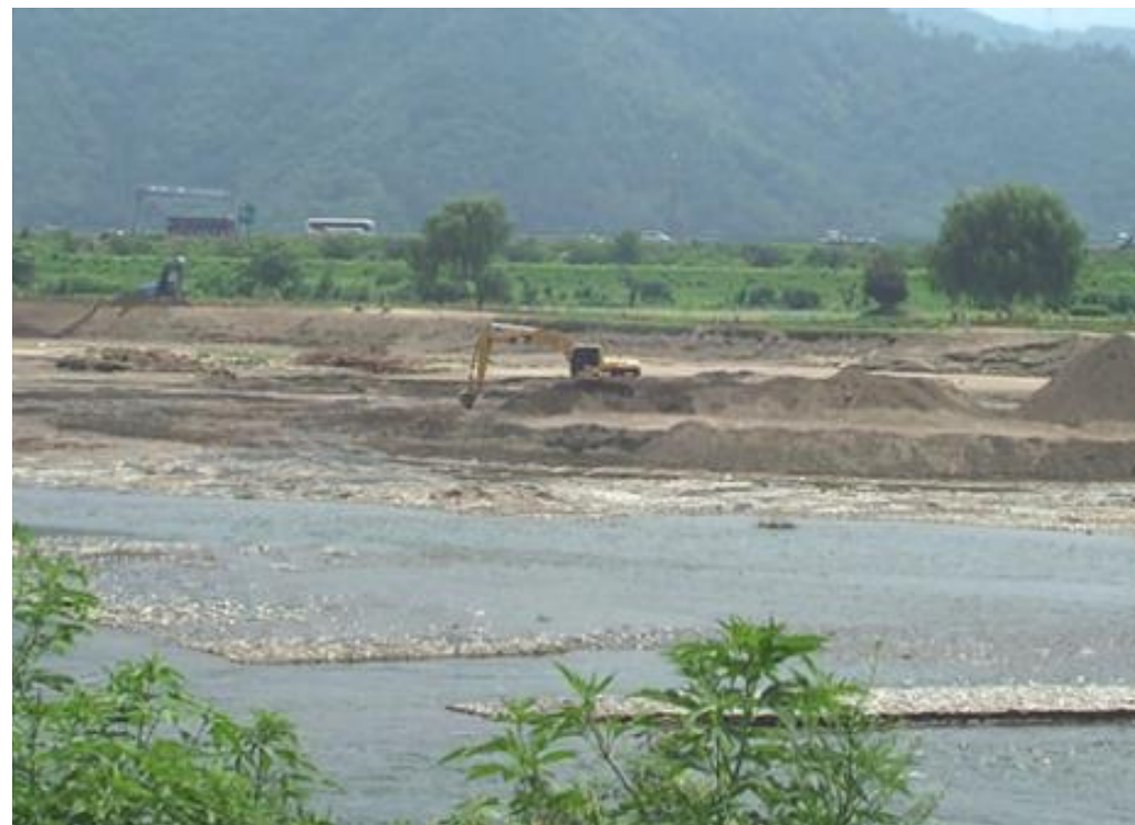
▲ 河道掘削状況
