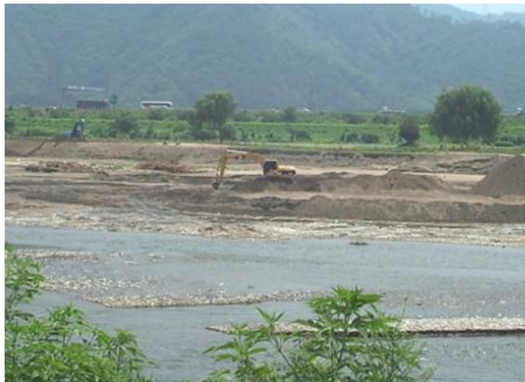
▲ 河道掘削状況
