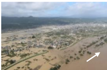
長野市穂保地先の堤防決壊、 浸水被害状況
