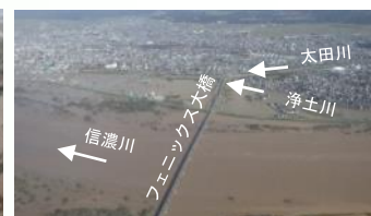
新潟県長岡市内における 浸水被害状況
