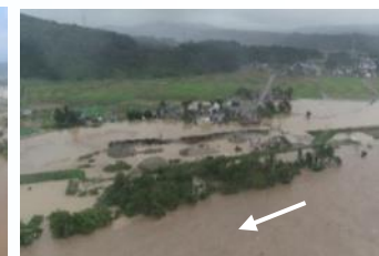
新潟県小千谷市内における 浸水被害状況
