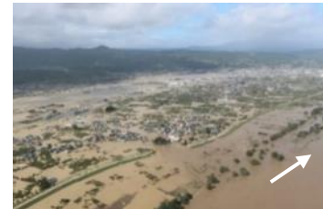
長野市穂保地先の堤防決壊、 浸水被害状況
