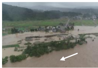
新潟県小千谷市内における 浸水被害状況
