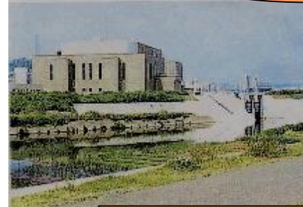
内水排除施設
