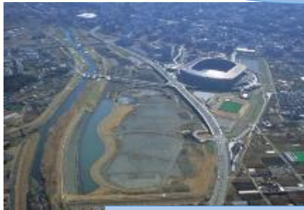
洪水調節施設
