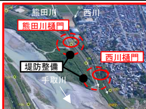
合流点処理（樋門設置・堤防整備）
