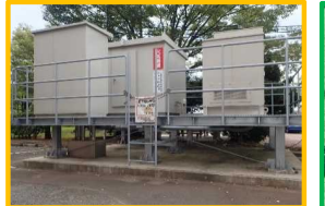
庁舎電気設備のかさ上げ（川北町）
