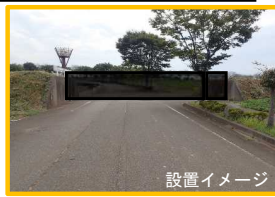
霞堤止水ゲートの設置（川北町）
