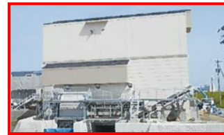
排水ポンプ場増強（小松市）
