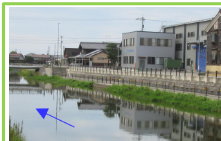
環境に配慮した護岸整備状況(水際環境の創出)
