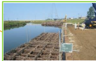
粗朶沈床施工状況(水際環境の創出)
