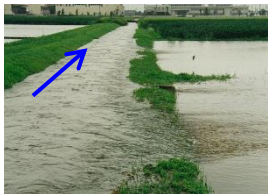
水路から溢水し農地等湛水
