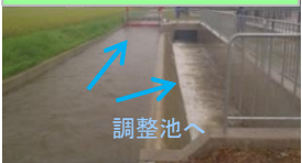
洪水調整池への流入（下流域溢水被害の未然防止）
