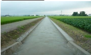
水路の改修（大断面化）
