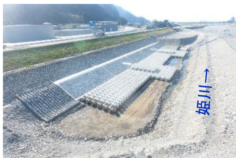
（根継ぎ護岸施工状況）
