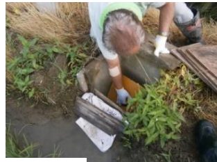
落水調整板の設置・更新
