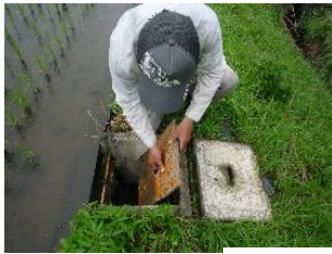
落水調整板の設置・更新
