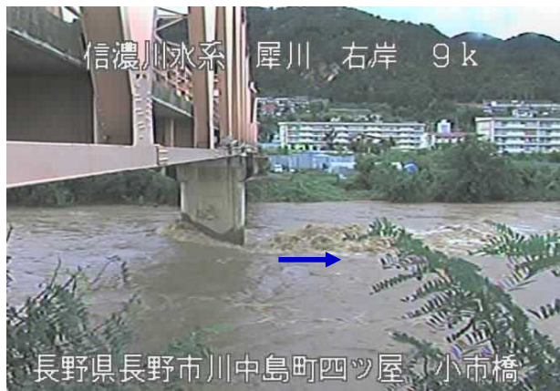
信濃川水系 犀川 右岸 9k 長野県長野市川中島町四ツ屋 小市橋 8/15 12:00 犀川右岸9k0 小市橋付近【長野市 川中島町】 (氾濫注意水位超過状況)
