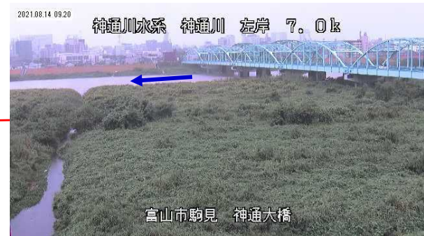
8/14 09:20 神通川左岸7k0 神通大橋付近【富山市駒見】 （氾濫注意水位超過状況）
