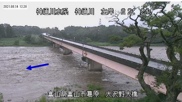
8/14 12:20 神通川左岸22k2 大沢野大橋付近【富山市葛原】
