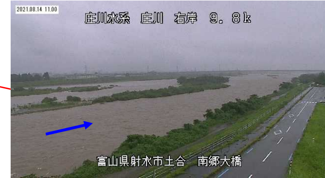
2021.08.14 11:00 庄川右岸9k8 南郷大橋付近【射水市土合】
