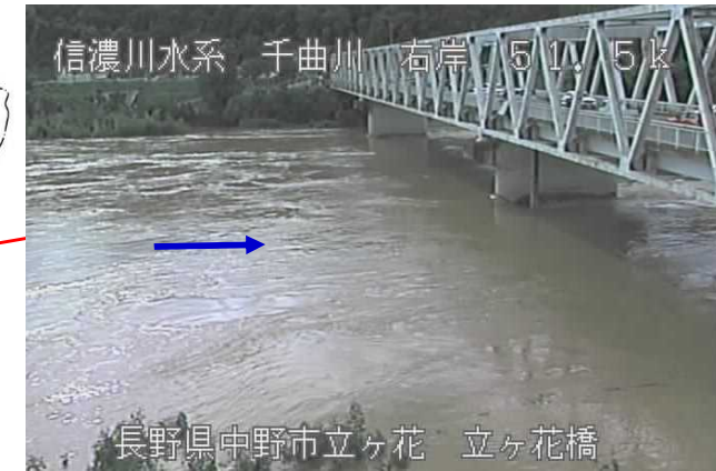
信濃川水系 千曲川 右岸 51.5k 長野県中野市立ヶ花 立ヶ花橋 8/15 15:20 千曲川右岸51.5k 立ヶ花橋付近【中野市立ヶ花】 (避難判断水位超過状況)
