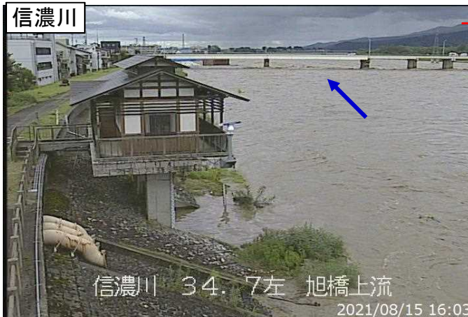
8/15 16:03 信濃川左岸34k7 旭橋上流付近【小千谷市元町】 (氾濫注意水位超過状況)
