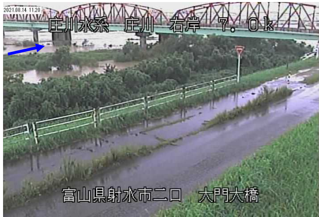
2021.08.14 11:20 庄川右岸7k0 大門大橋付近【射水市二口】 (氾濫注意水位超過状況)
