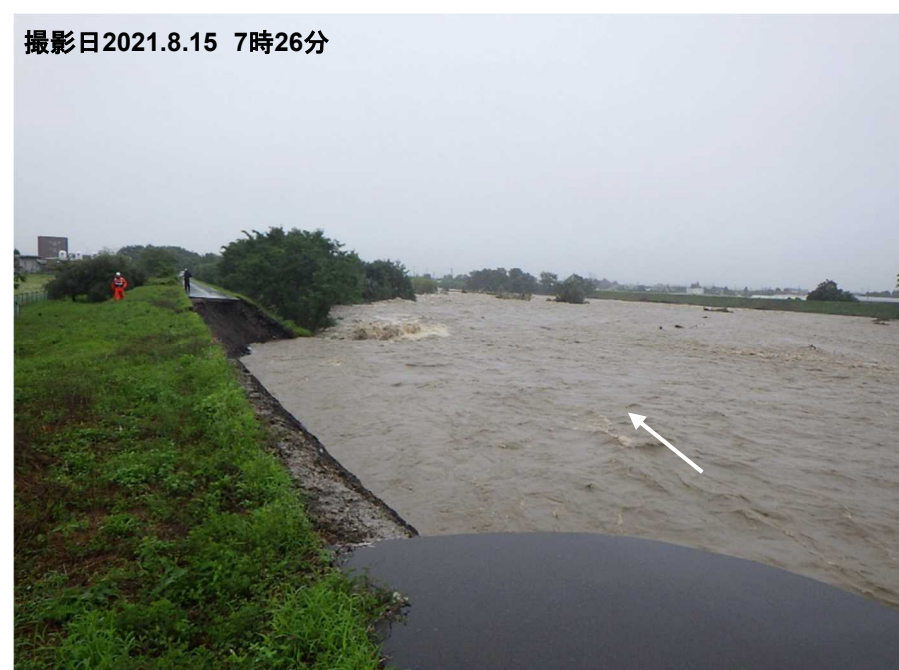
犀川左岸77.25K付近 被災状況 上流より（松本市上大妻地先）
