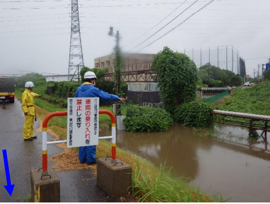
川裏浸水状況 (小矢部川左岸3.6k)
