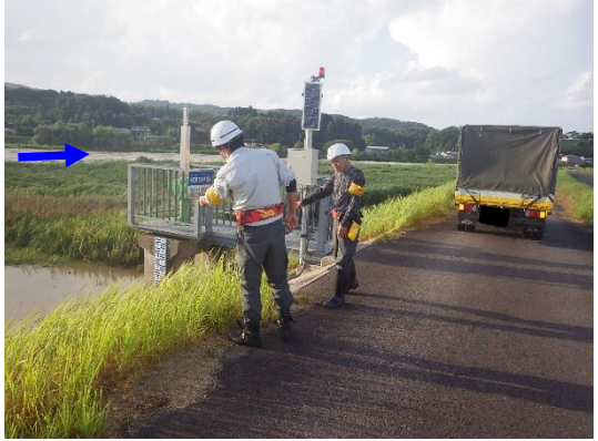
構造物状況 (小矢部川右岸3.6k)
