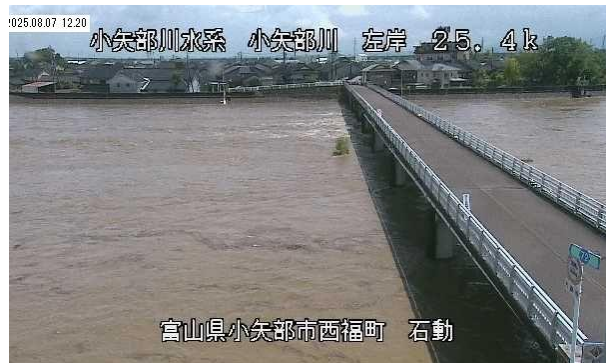
小矢部川 石動観測所付近 （8月7日 12:20頃）
