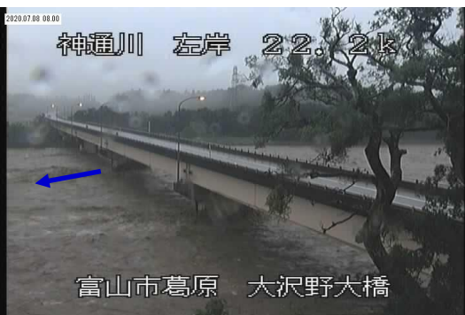
7/8 08:00 神通川左岸22k2 大沢野大橋付近
