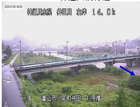
7/8 08:00 井田川右岸14k0 杉原橋付近
