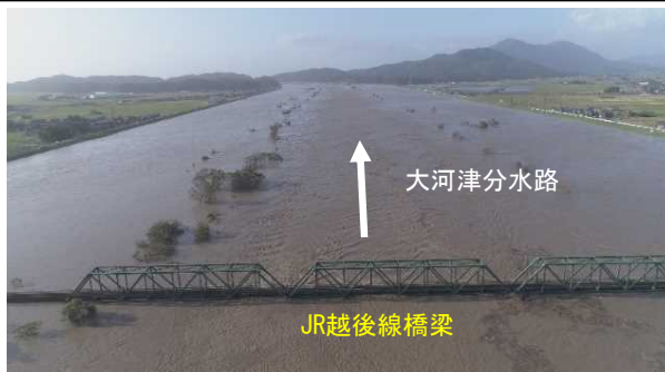
JR越後線橋梁より下流を望む (10/13 15:37撮影)
