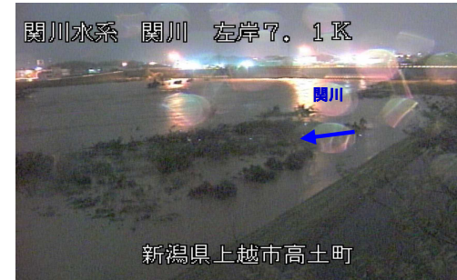
10/13 0:28 関川左岸7k1 高土町付近
