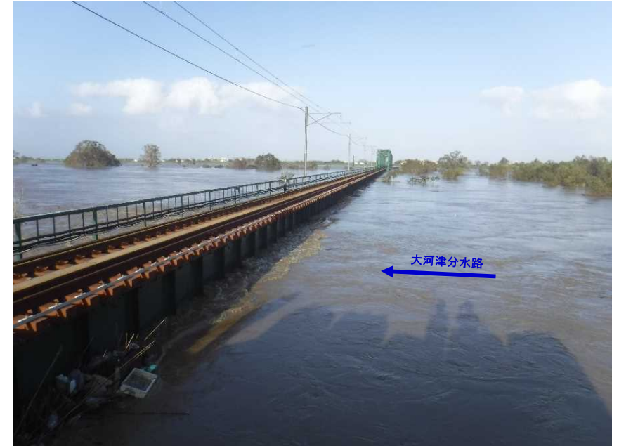
10/13 15:42 大河津分水路左岸1k8 JR越後線 信濃川分水橋梁付近
