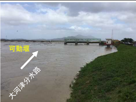
上流より可動堰を望む (10/13 10:03撮影)
