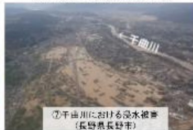
【令和元年東日本台風】
